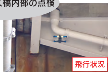
実証例：トラス橋内部の点検
