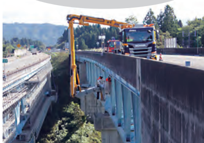
点検作業による交通規制の実施
